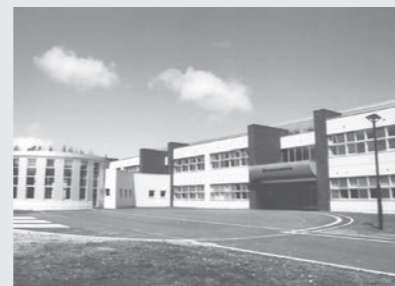
清里中学校冷房設備設置工事 2,397万6千円
