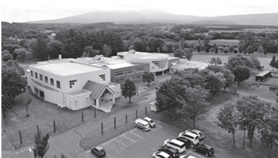
引き続き大規模改修を行う清里小学校
