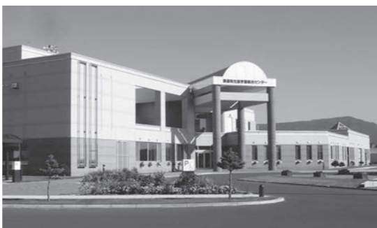
引き続き冷暖房設備工事を行うプラネット'97
