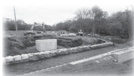
清流橋架換工事
